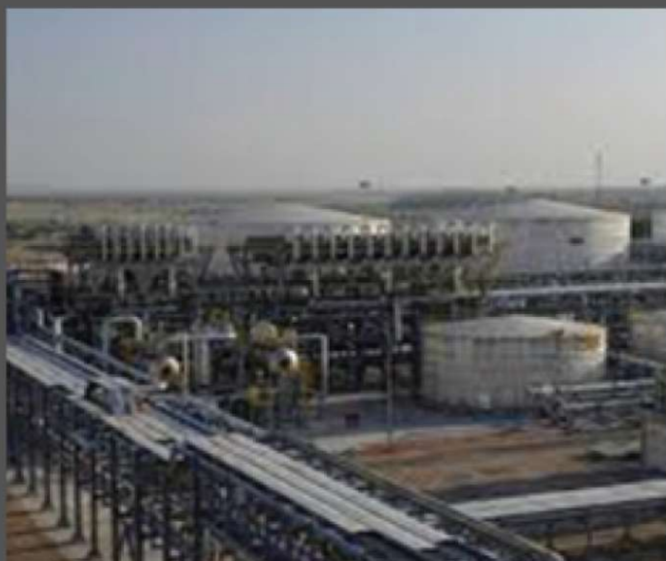
Oil & Gas / LNG
